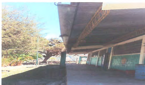
Foto 2: REMOZAMIENTO DE BAJADA DE CANALES PLUBIALES
