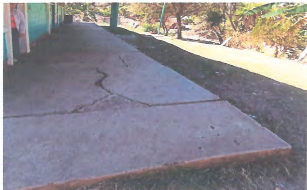
Foto 1: REMOZAMIENTO DE PISO
