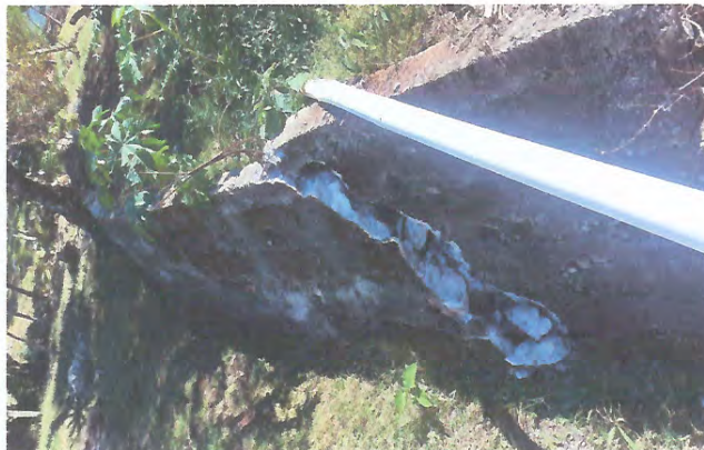
Foto 4: REMOZAMIENTO MURO DE CONTENCIÓN
