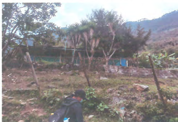
Foto 3: REMOZAMIENTO DE MURO DE CONTENCIÓN
